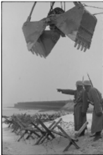
Référence : LFT3 F3129 L15 / Légende : A Calais, travaux d'aménagement. La défense rapprochée du port est assurée par la batterie de 8,8 cm Flak 18 du Bastion XII défendue par les Schwere Flak-Abteilung.501./ Date : Hiver 1943-44 / Reporter : Engelmann (Luftflotte 3)
