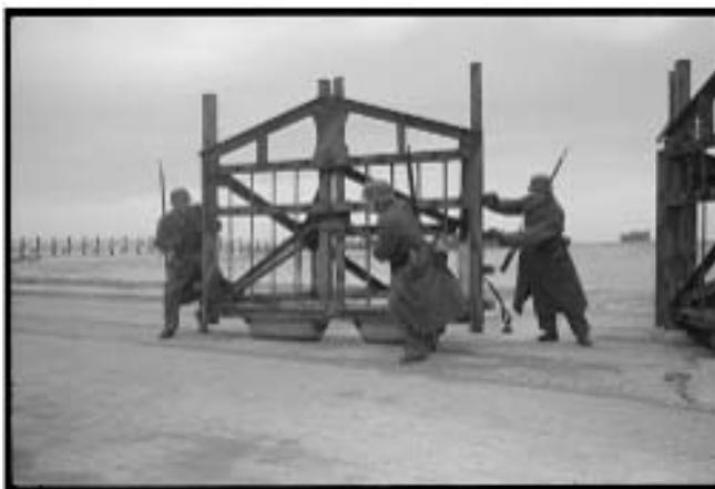
Référence : LFT3 F3103 L16 / Légende : A Calais, pose d'éléments « Cointet » dit aussi « porte belge » ou encore « élément C ». / Date : Hiver 1943-44 / Reporter : Engelmann (Luftflotte 3)
