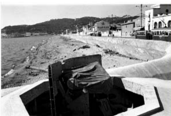
Référence : DAA 3313 L16 / Légende : A Marseille, sur la plage du Prado, un épais mur antichar est venu remplacer les postes de combat rudimentaires et les sacs de sable. Une portion est achevée le 15 mars 1943. La plage de Marseille est défendue par deux canons de 5 cm K.w.k 39 (KampfwagenKanone) qui la prennent en enfilade. / Date : été 1943 / Reporter : Schnitzer, Hans-Georg (Kriegsberichterzug XI.Flieger-Korps)
