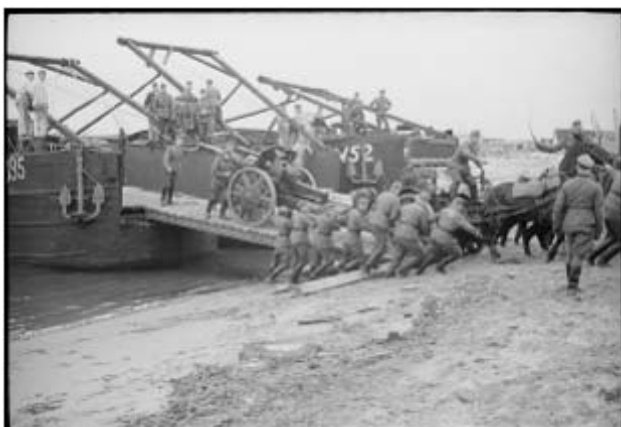
Référence : DAM 257 L24 / Légende : Dans le secteur d'Ostende, d'autres modifications apportées à des péniches. Ici, un portique permet le positionnement d'une rampe d'accès pour le déchargement du matériel. / Date : septembre 1940 / Reporter : Inconnu
