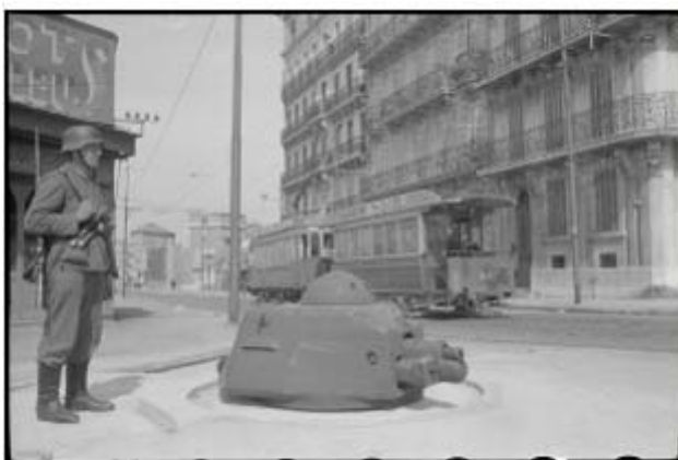
Référence : DAT 615 L09 / Légende : Aménagement d'ouvrages du "Mur du Sud" (Südwall) sur l'avant-port Joliette de Marseille. Une tourelle de char Renault R35 utilisé dans un Tobrouk, derrière la brasserie "les flots bleus". / Date : 1943 / Reporter : Gebauer (Propagandakompanie Pk.637)
