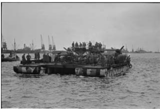
Référence : DAM 264 L11 / Légende : Essais de navigation d'un ponton motorisé (Marinefährrahm) à l'aide de moteurs d'avions, portant du matériel
