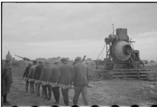
Référence : DAT 754 L01 / Légende : Construction d'ouvrages du mur de l'Atlantique à Ostende (Mariawerke). / Date : Inconnue / Reporter : Inconnu
