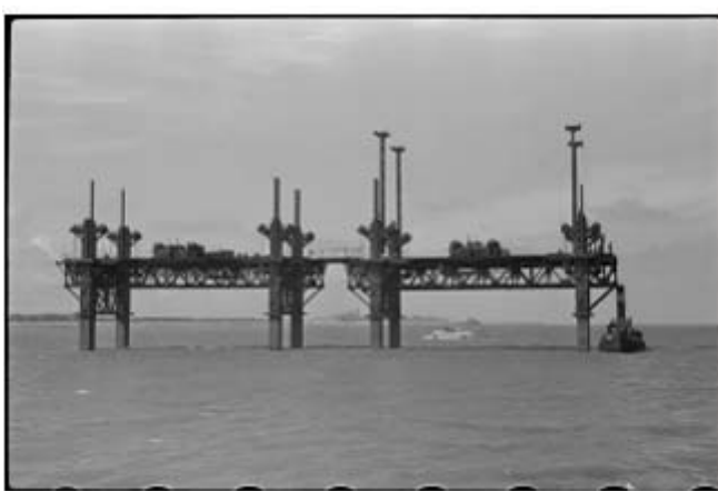
Référence : DAT 762 L07 / Légende : Au large de Zeebrugge, une jetée artificielle est montée pour en tester l'efficacité avant l'opération "Seelöwe". Devant les éventuelles difficultés de déchargement du matériel sur les côtes anglaises, cette jetée aurait permis un transfert rapide du matériel depuis un
